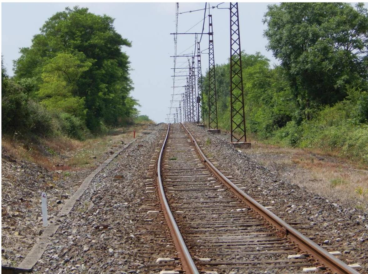
Dans cette zone, ici au PK 514,1, la voie n'est pas si mal, malgré un certain mélange du côté des traverses (rail et traverses sont de 1963, hormis évidemment les traverses en béton, d'âge variable) :
