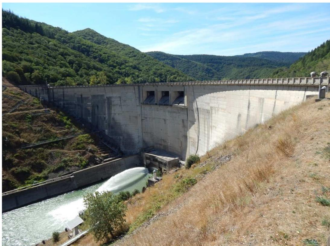
... et on a l'impression qu'il manque quelque chose : la ligne à haute tension... En effet ! Car il y a bien une centrale, mais minuscule : 1,3 MW (Serre-Ponçon : 380). Ce barrage sert surtout à maintenir l'étiage du fleuve et donc à permettre un certain degré d'irrigation (et de fourniture d'eau aux populations) en aval, au printemps et en été. Hauteur du barrage : 62 m. Superficie de la retenue 1,8 km<sup>2</sup> (Serre-Ponçon : 28).
